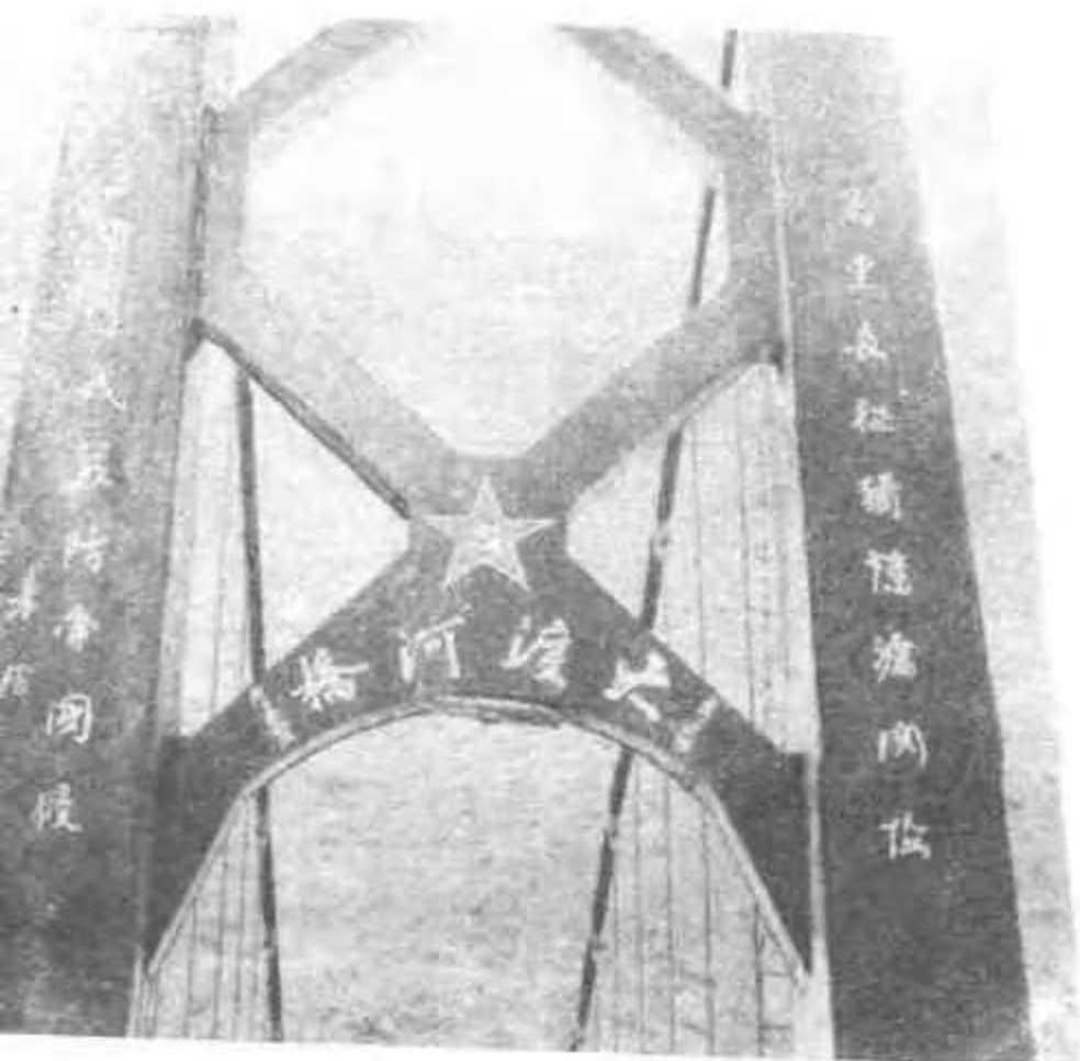
朱德、刘伯承题词的泸定钢缆公路桥
