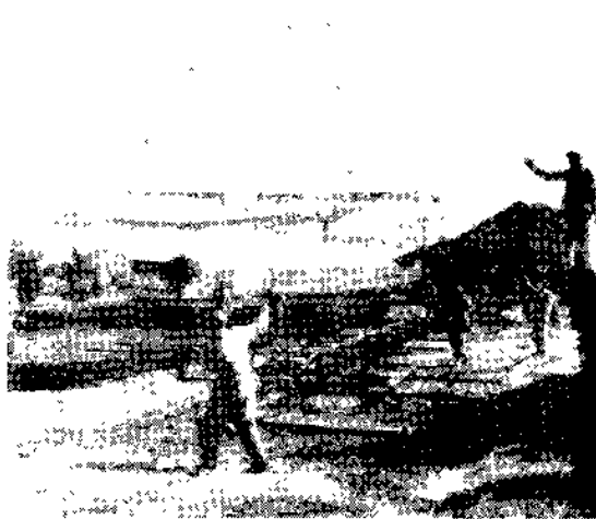
工程兵在虹桥机场编扎钢筋网
